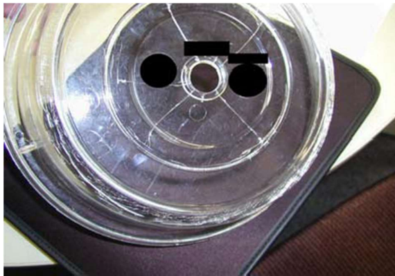
Abbildung 1: Spannungsrisse in Abdeckung aus PC (Quelle: Ecolab)
